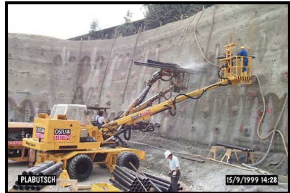
Plabutsch Tunnel - slope protection
