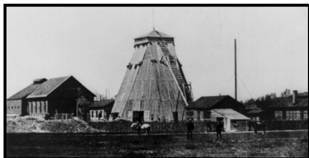
Shaft Sinking 1872 - Deutscher Kaiser I
