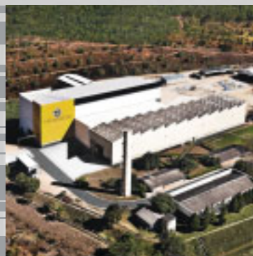
Vista aérea - Tecnometal Engenharia Vespasiano - MG Aerial View - Tecnometal Engenharia
